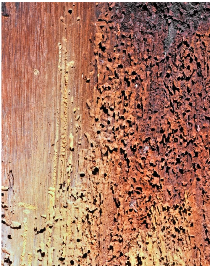
Aantasting van een zestiende-eeuwse eikenkozijnstijl door kleine houtworm (Anobium punctatum)
