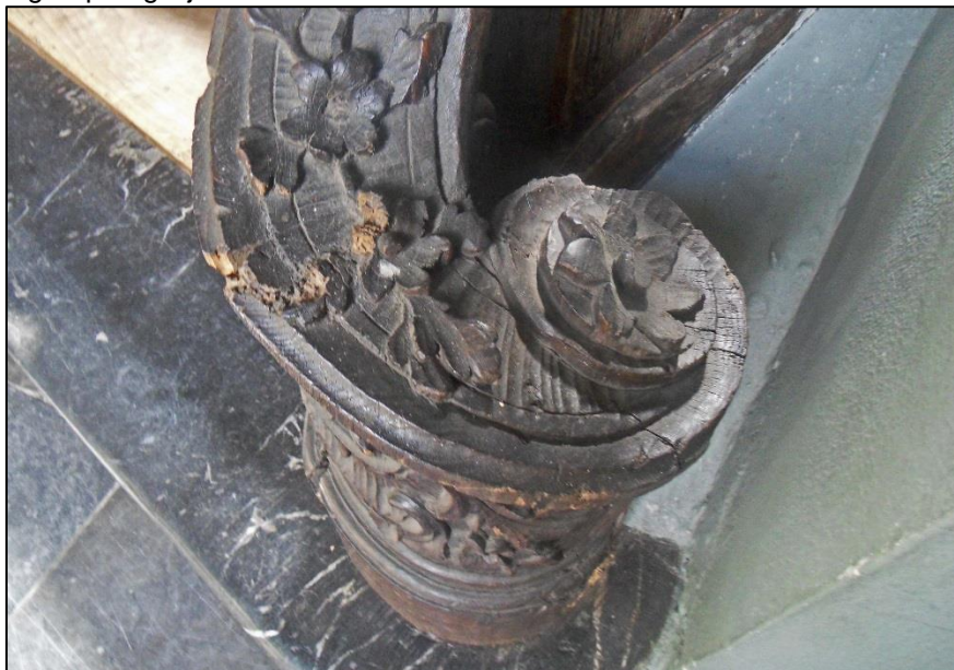
Categorie 1 Conserveren van een gesneden wrongstuk van een balustrade
