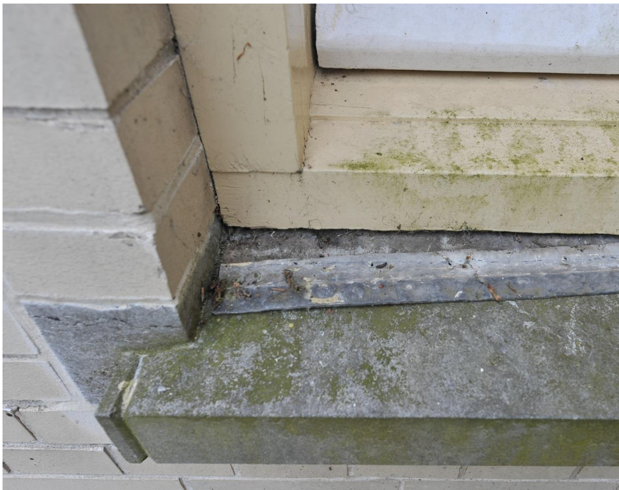
In bovenstaand voorbeeld is de loodslabbe tussen kozijndorpel en stenen weldorpel te smal en bevestigd met (inmiddels roestende ) spijkers. Bevestiging met latten had een beter resultaat geleverd.
